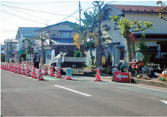
ガスの配管工事で、父親が創業
